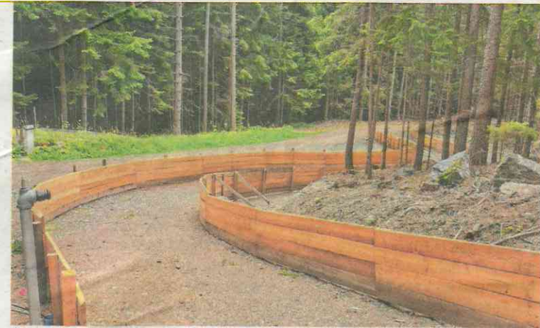
▲ Bis Ende Oktober soll die Bahn saniert sein.
